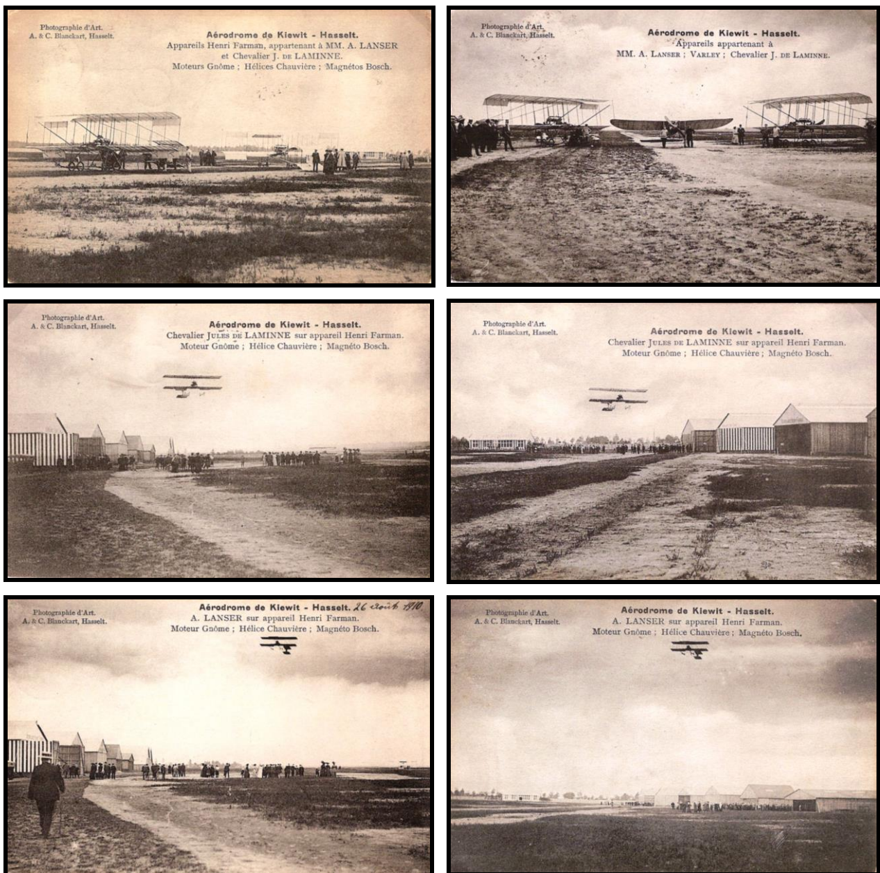
Figure 3 : Différentes vues de l'aérodrome de KIEWIT - HASSELT.
