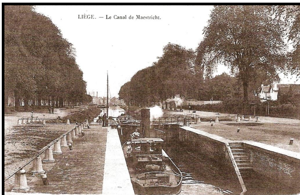
Fig. 17 : Vue du canal de Maestricht à Liège.
